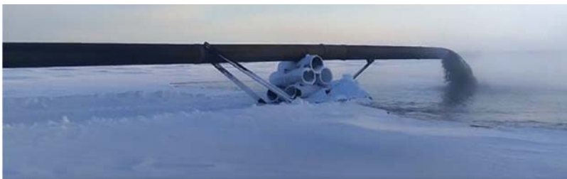
Рис. 7. Торцевой сброс T4 подлёдного складирования на XX ОФЗ МНГОК
